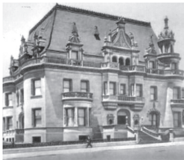
Das Haus des Auswanderers Claus Spreckels, des „Zuckerkönigs“, in San Francisco. Das Gebäude wurde beim Erdbeben von 1906 stark beschädigt.
