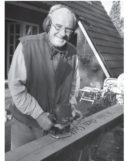
Mit dem Oberfräser werden die Buchstaben nachgehend ins Eichenholz geschnitten (Jens Dircksen)
