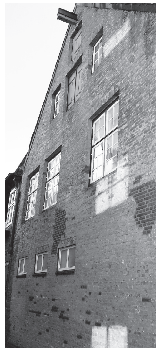
Die Stassenseitenansicht des Gebäudes.
