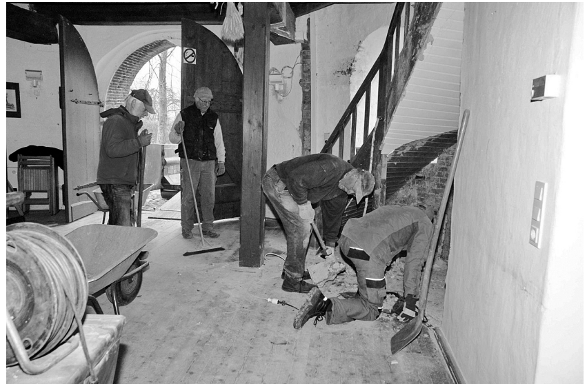
In Eigenarbeit von Mitgliedern des Mühlenvereins werden nachträgliche Einbauten in der Mühle entfernt. (Foto: Heinrich Schröder)
