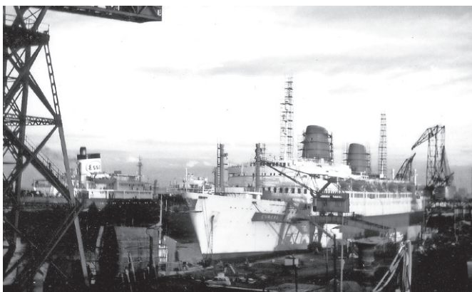
Links: Die EUROPA erhält im Technischen Betrieb des NDL in Bremerhaven den reedereitypischen Anstrich mit schwarzem Rumpf, weißen Aufbauten und ockergelben Schornsteinen. (Foto: Archiv Deutsches Schifffahrtsmuseum)
